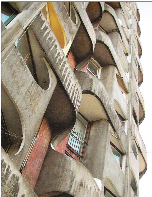
9. Zespół mieszkaniowo-usługowy przy Placu Grunwaldzkim we Wrocławiu, fragment elewacji.
