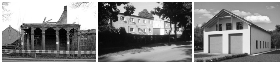
Żuławy – zniszczony dom podcieniowy
