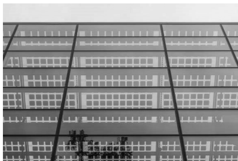
Fot. 7. Przykład innego sposobu integracji ogniw PV ze strukturą budynku. W tym przypadku moduły wklejone są bezpośrednio w szklenie zadania, tworząc dodatkowe zacielenie wnętrza obiektu. Budynek WFOŚiGW w Łodzi
