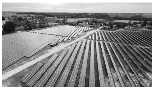
Fot. 5. Farma fotowoltaiczna o mocy 4MW wybudowana przez koncern Energa w Czernikowie pod Toruniem jest obecnie jedną z największych inwestycji w fotowoltaikę w Polsce
