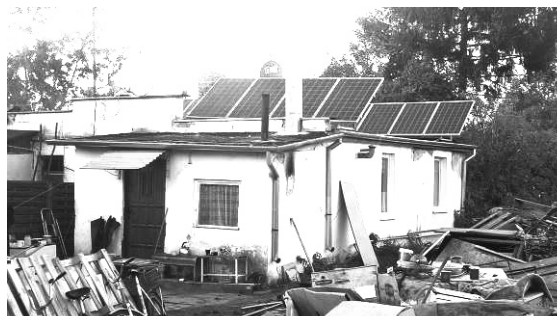
Fot. 3. Zespół paneli PV na budynku mieszkalnym w Gdańsku, stanowiących osobną, obcą strukturę na dachu obiektu
