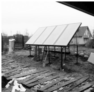
Fot. 2. Kolektory słoneczne jako wolnostojąca instalacja przy budynku mieszkalnym w Warzeniu (woj. pomorskie)
