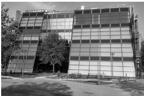
Fot. 6. Przykład jednego ze sposobów integracji paneli PV z fasadą. Panele PV są skorelowane z wymiarami pozostałych elementów fasady i wkomponowane tak, że tworzą ciekawą, jednorodną, estetyczną powierzchnię
