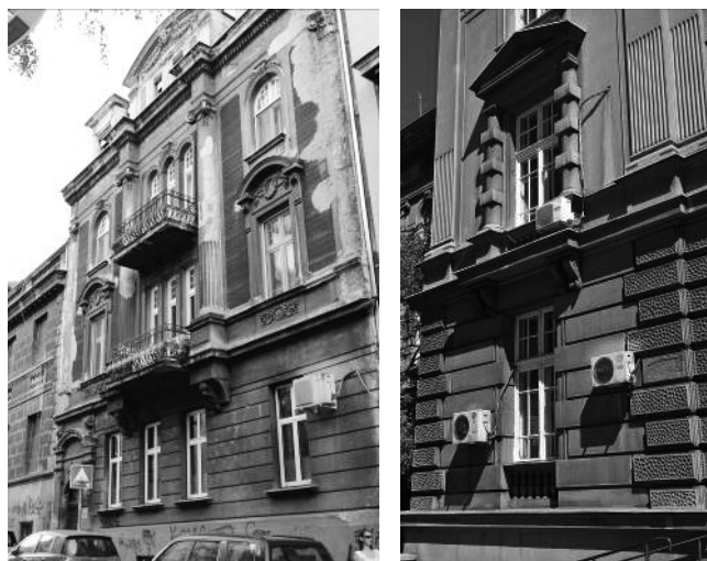
Fot. 1. Urządzenia techniczne (klimatyzatory) na budynkach historycznych w Belgradzie (Serbia)
