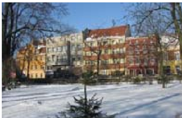
Il. 10. Odrestaurowany ciąg domów wzdłuż głównej ulicy Bolesława Krzywoustego na Psim Polu, Wrocław. Fot. Z. Borcz
