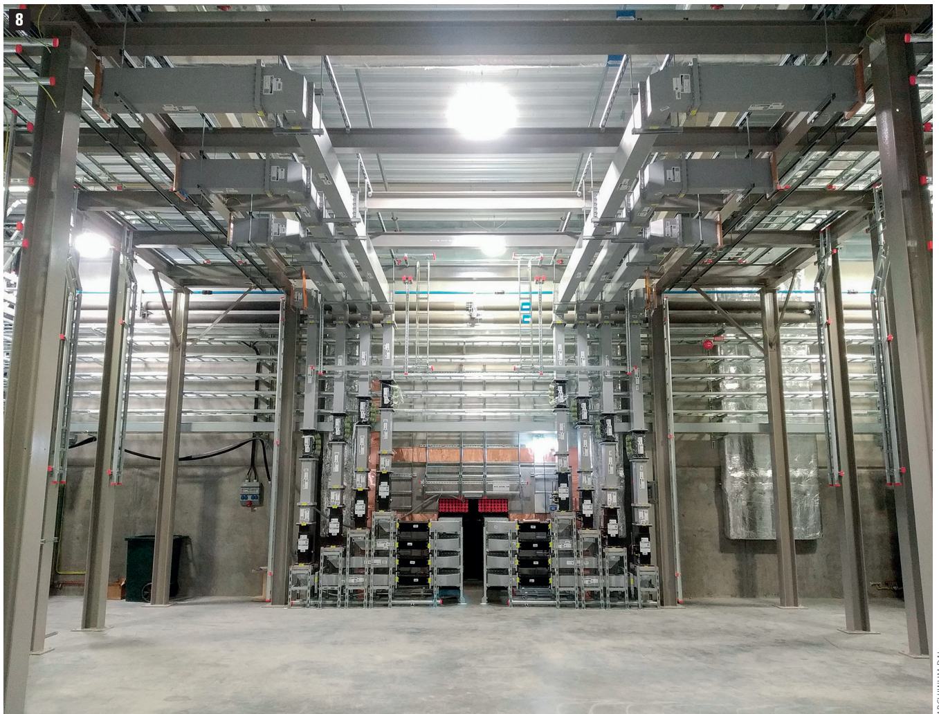
Fot. 8 System dystrybucji mocy (RF) – falowody 704 MHz gotowe do strojenia
