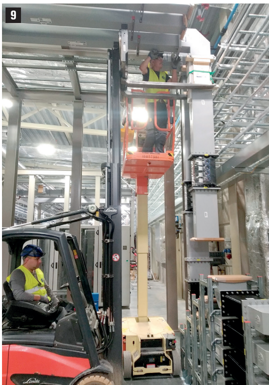
Fot. 8 System dystrybucji mocy (RF) – falowody 704 MHz gotowe do strojenia
