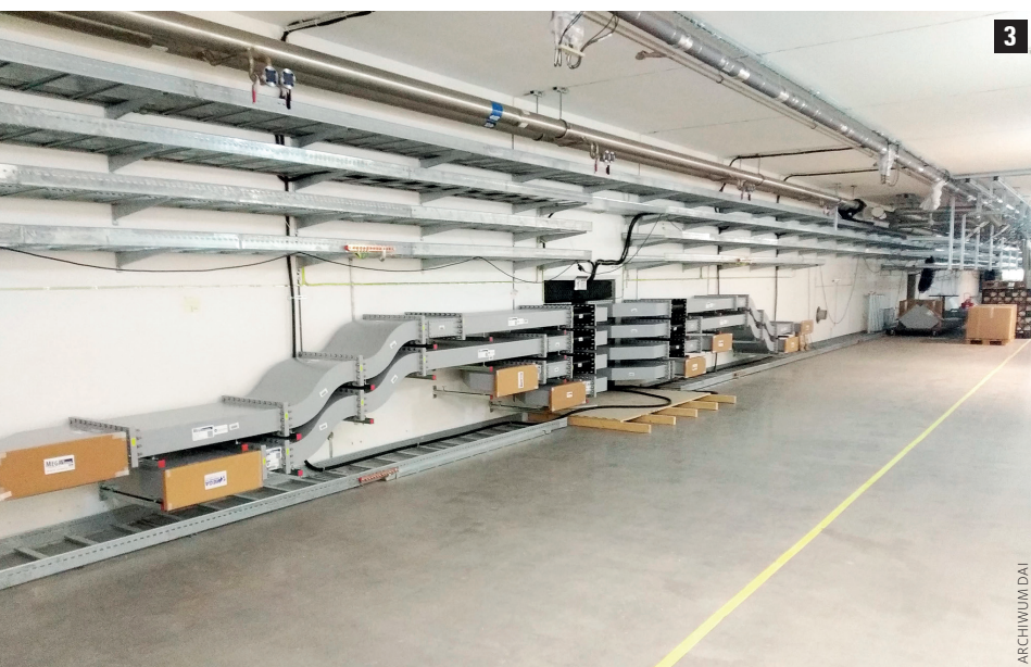
Fot. 1 Instalacja falowodów w tunelu akceleratora
