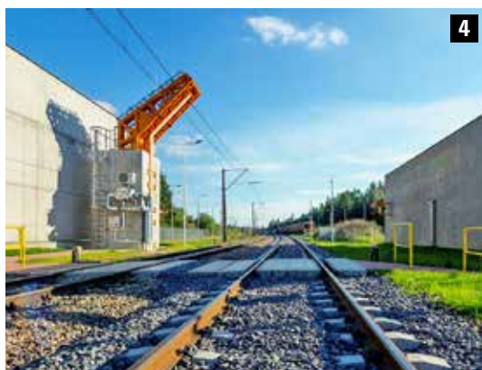
Fot. 4 System CANIS prześwietla wagony kolejowe wjeżdżające na teren Unii Europejskiej
