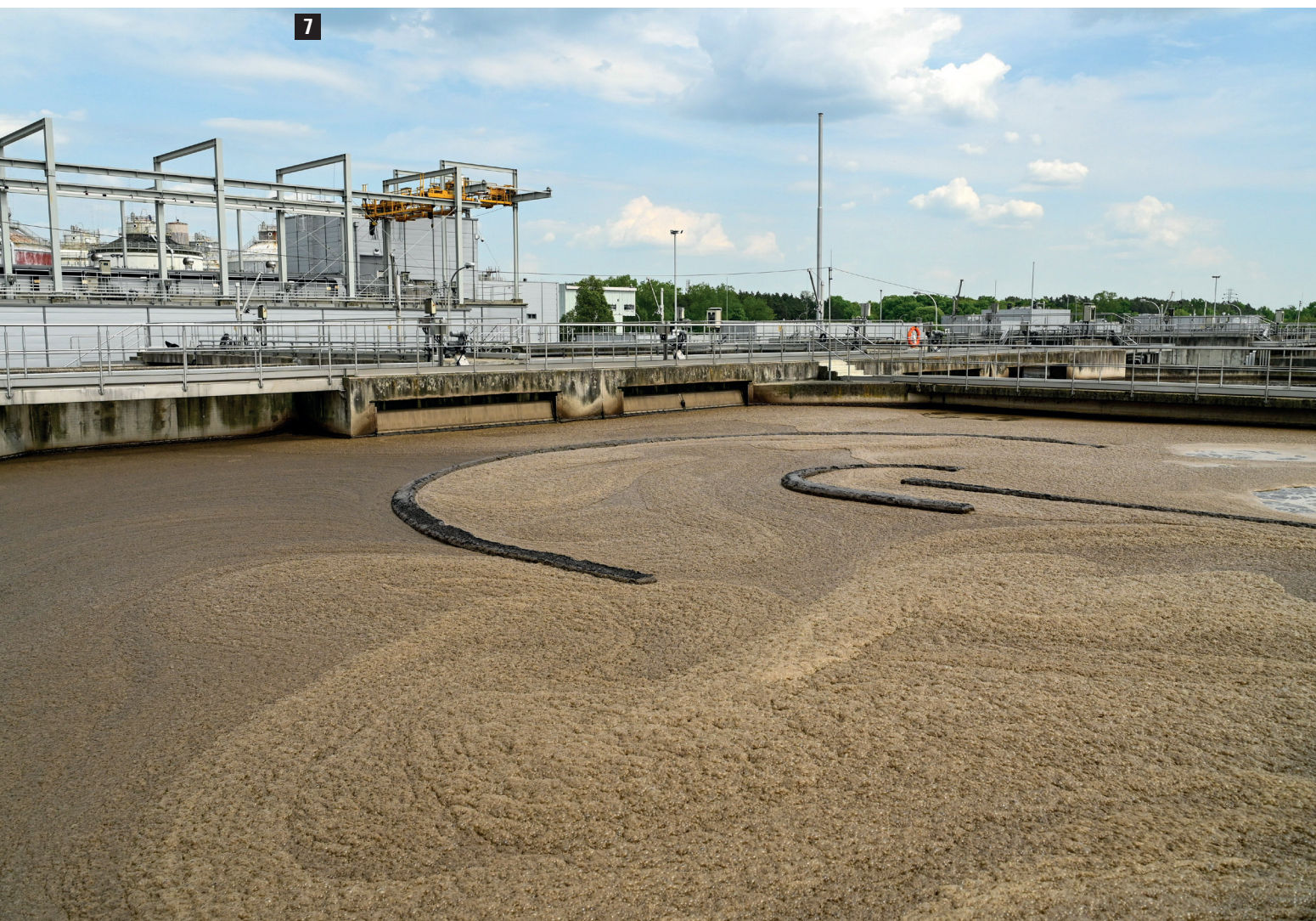
Fot. 7 Widok na pracujący reaktor biologiczny
