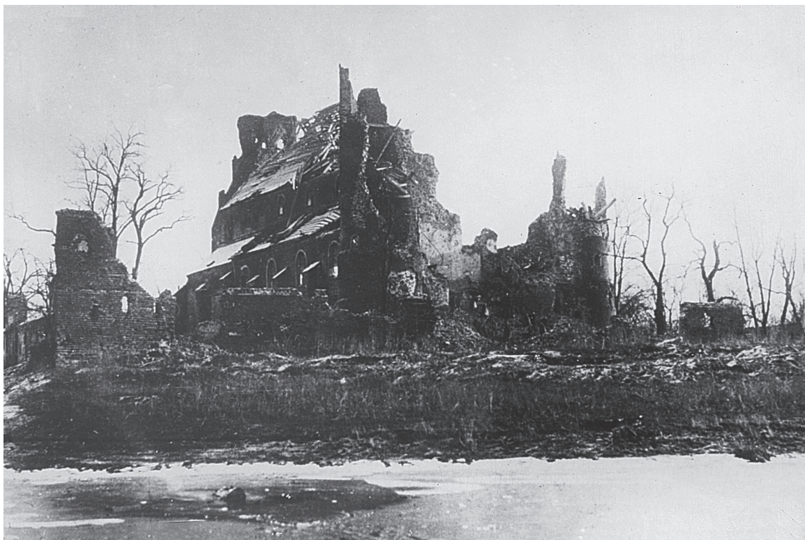
4. Brochów, kościół parafialny po 1915. Fot. ze zbiorów Zakładu Architektury Polskiej WAPW
