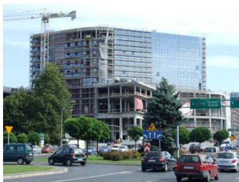
Fot. 10. Widok na City Center. Źródło: B. Krupa, K. Konieczna
