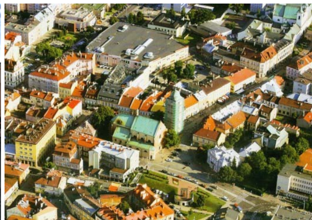
Fot. 2. Widok na kościół farny od strony ulicy 3 Maja i od rynku (widok z góry). Źródło: J. Ambrozowicz
