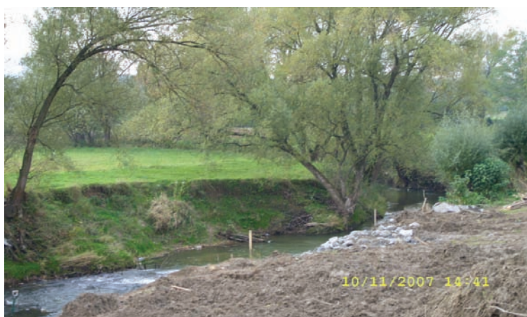
Rys. 2. Stabilizacja brzegu rzeki Stobnica
