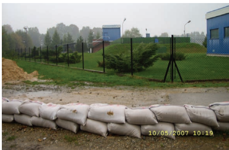
Rys. 6. Oczyszczalnia ścieków w Zasole Bielańskim (gm. Wilamowice) zagrożona wysokim stanem Soły we wrześniu 2007 r. Fig. 6. Sewage treatment plant at Zasole Bielańskie (the Wilamowice commune) endangered with high level of water in the Soła in September 2007
