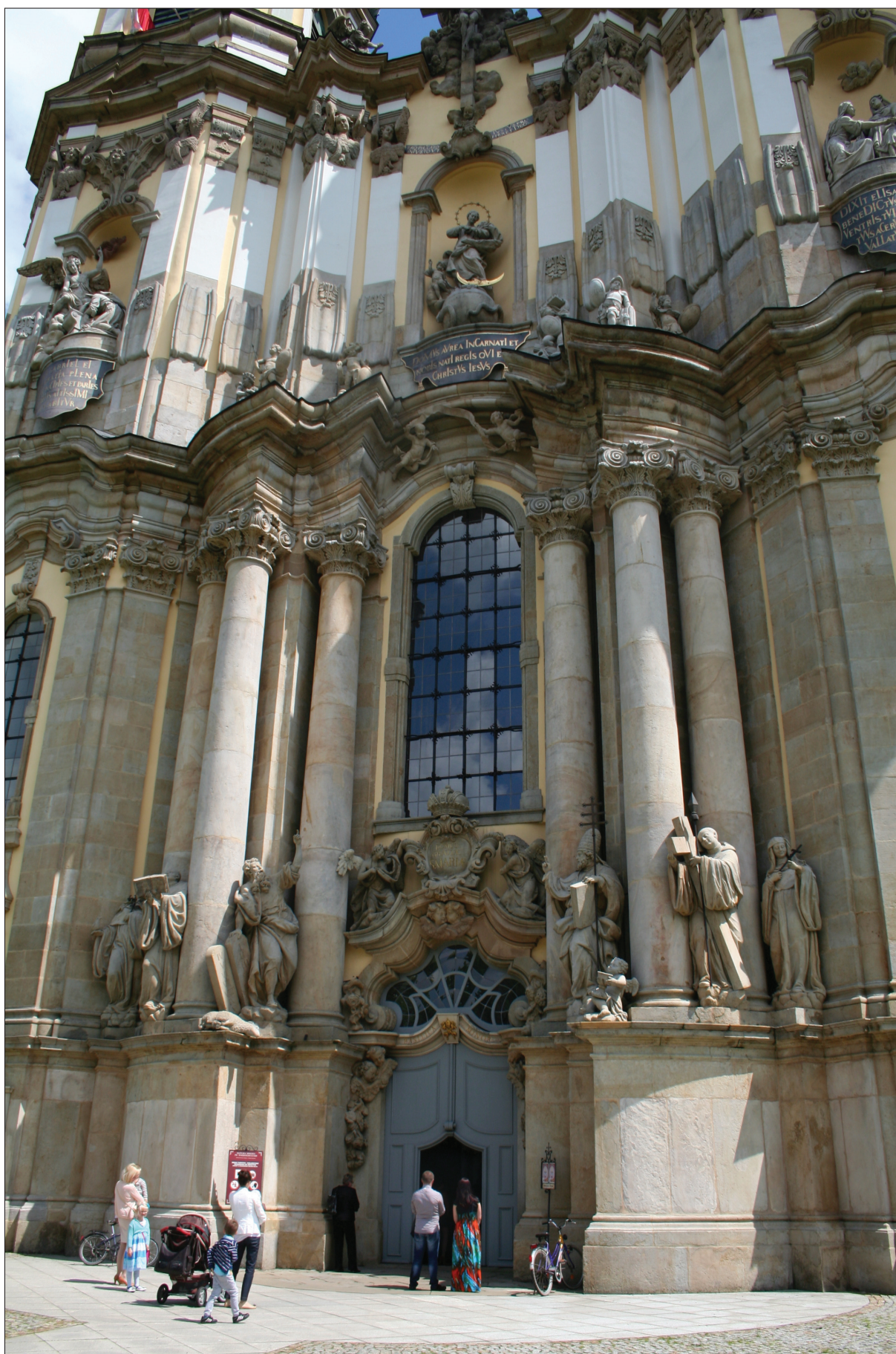
16. Portal główny bazyliki w Krzeszowie. Fot. autor, 2014 16. Main portal of the Basilica in Krzeszów. Photo by the author, 2014
