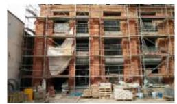
Rys. 2 Wbudowana zabytkowa cegła w nowopowstającą konstrukcję 21.03.2017, archiwum własne
