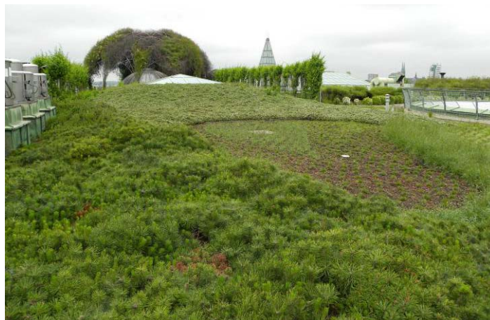
Ryc. 4. Ogród srebrny na dachu Biblioteki Uniwersytetu Warszawskiego (fot. M. Dudkiewicz)
