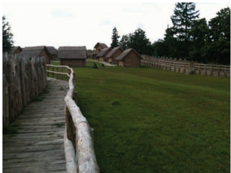
Fot. 6. Taras grodziska po zagospodarowaniu (autor: J. Rayss)
