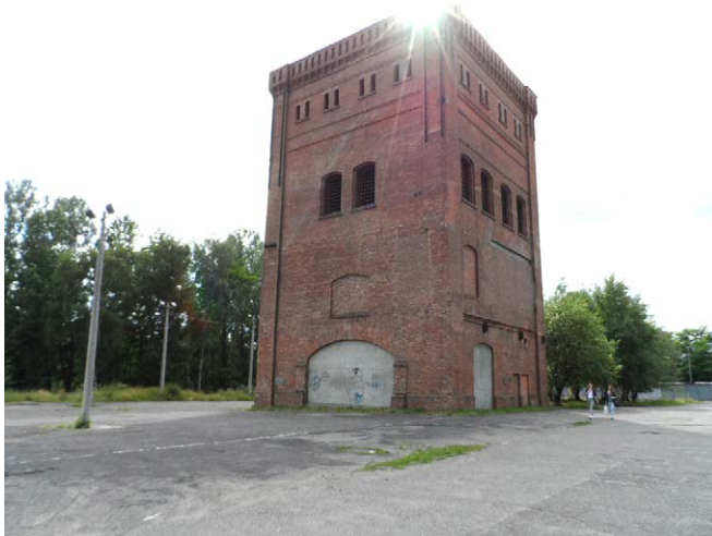
Fot. 2. Wybrany obszar rewaloryzacji w Rudzie Śląskiej – otoczenie pokopalnianego szybu „Andrzej”
