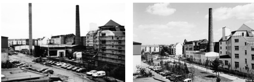
Fot. 21 i 22. Henriettenpark przed i po rewitalizacji
