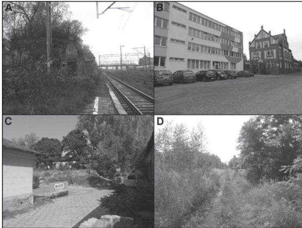
Fot. 1. Zaniedbane perony (A) i kontrastujący z historyczną zabudową biurowiec w Nowych Skalmierzycach (B) oraz pozostałości wyburzonej zabytkowej komory celnej (C) i sukcesja roślinna na terenie dawnej towarowej stacji szerokotorowej w Sosnowcu Maczkach (D)
