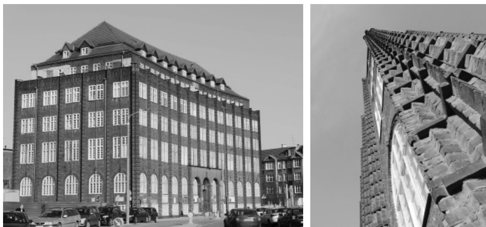
Fot. 6. A. Bielefeldt – budynek dawnej Kasy Chorych (1926-28), Gdańsk – elewacja frontowa
