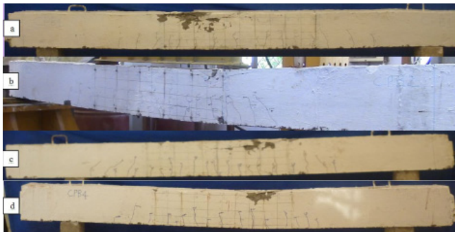
Fig. 10. Crack pattern of beam: (a) CPB1-2-H-0.63, (b) CPB2-2-V-0.52, (c) CPB3-1-H-0.37, (d) CPB4-1-H-0.68
