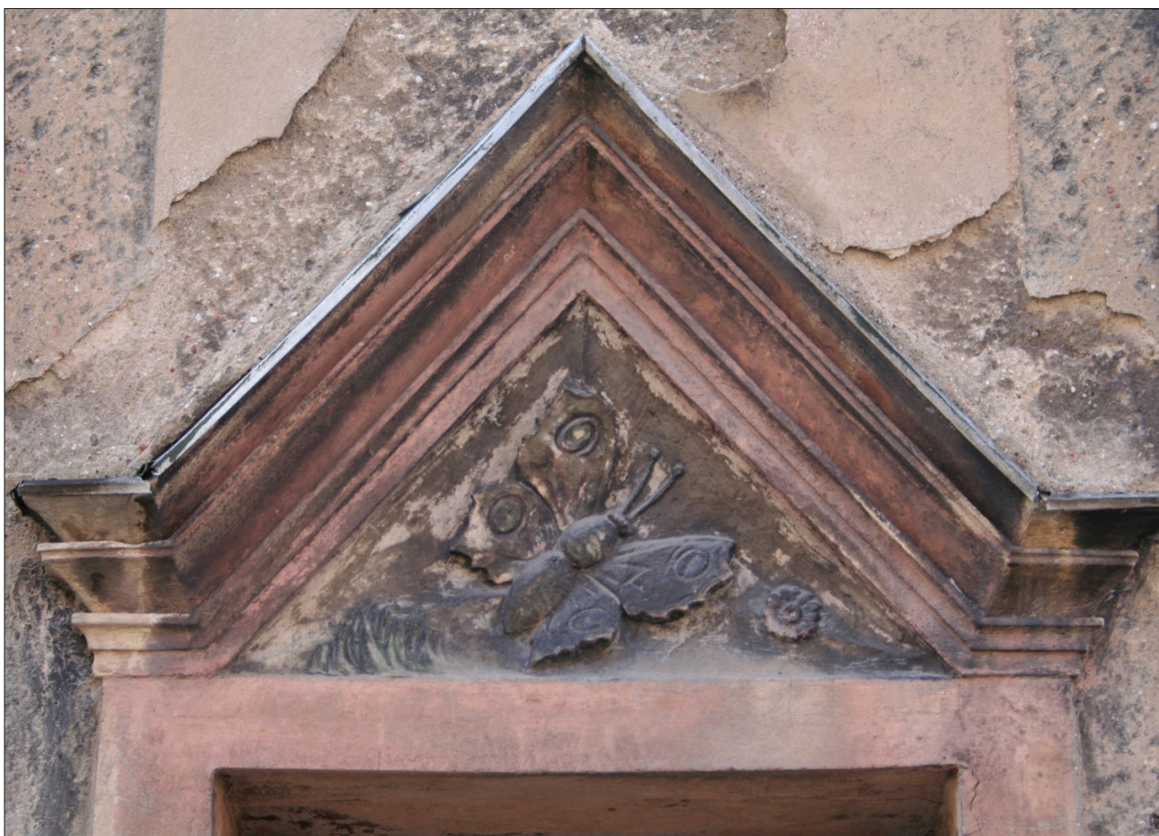
1. Tympanon portalu o gzymsach zgeometryzowanych nawiązujących do klasycznych wzorów w budynku modernistycznym na Nowym Mieście przy ul. A. Fredry w Wałbrzychu, 1925 r. Fot. autor, 2008 r.
