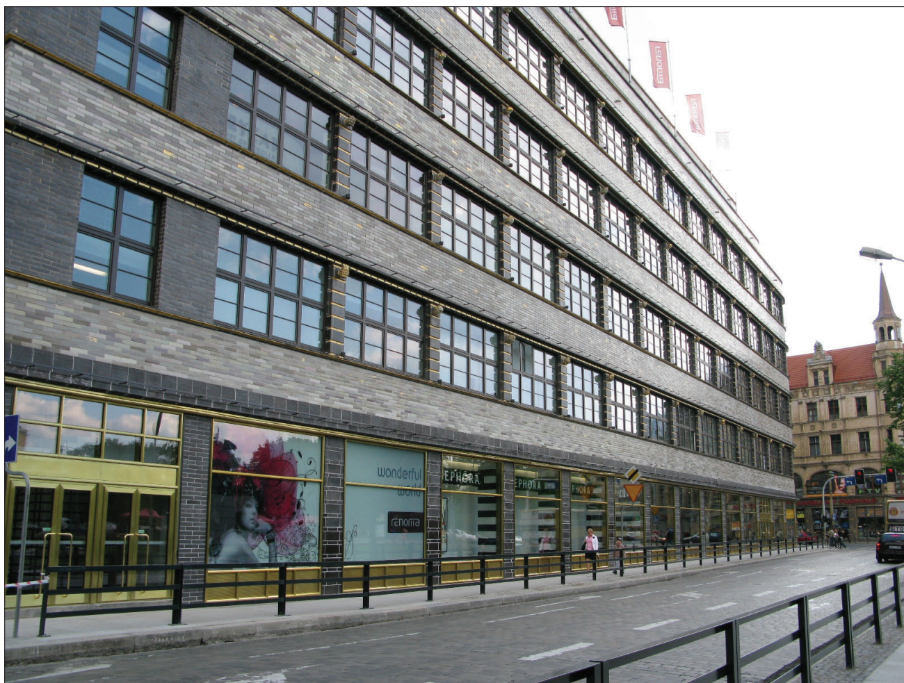
2. Elewacja szklano-ceramiczna budynku domu towarowego „Renoma” dawniej „Wartheim” ukrywająca stalową konstrukcję, 1928 r. Fot. S. Wróblewski, 2012 r.
