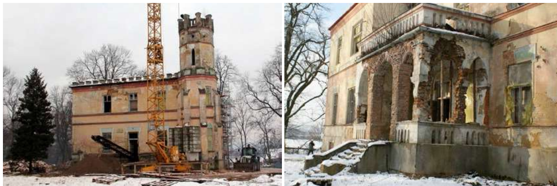
Ryc. 1. Pałac w Cianowicach, widok bryły pałacu, stan przed modernizacją, 2011 (źródło: dokumentacja Właściciela obiektu, dostęp 2015)
