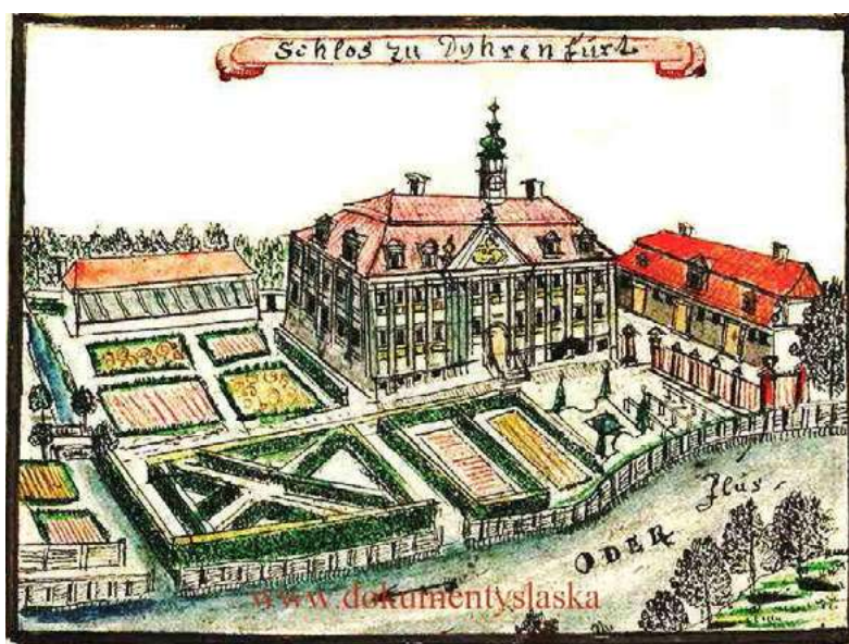
Ryc. 4. Fryderyk Bernard Wernher, Widok Pałacu w Brzegu Dolnym z lotu ptaka, ok. 1740 r. [Archiwum Wrocławskie] Fig. 1. Fryderyk Bernard Wernher, View of the Palace of the Brzeg Dolny bird's eye view, approx. 1740.
