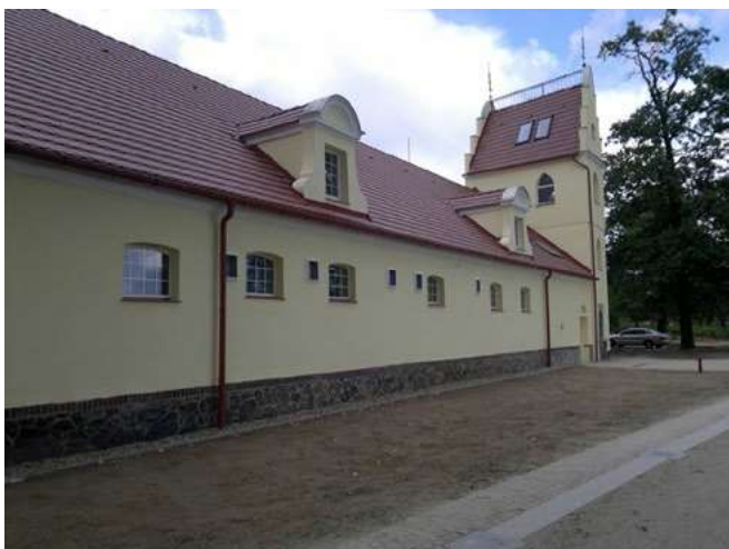
Ryc. 12. Widok obiektu od strony bulwaru wzdłuż koryta Odry sprzed i po realizacji, foto autorki
