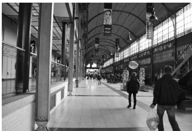
Ryc. 52. Dworzec Wrocław Główny, hol dworcowy, lokalizacja komercyjnych lokali usługowych na tarasach – dawnych peronach; stalowa konstrukcja hali harmonizuje ze neogotyckim stylem architektonicznym budynku; pojedyncze elementy wskazujące na funkcje kulturalne (tu instalacja z książek wskazująca na wypożyczalnię książek na podróz), fot. W. Jabłoński, październik 2016 r.
