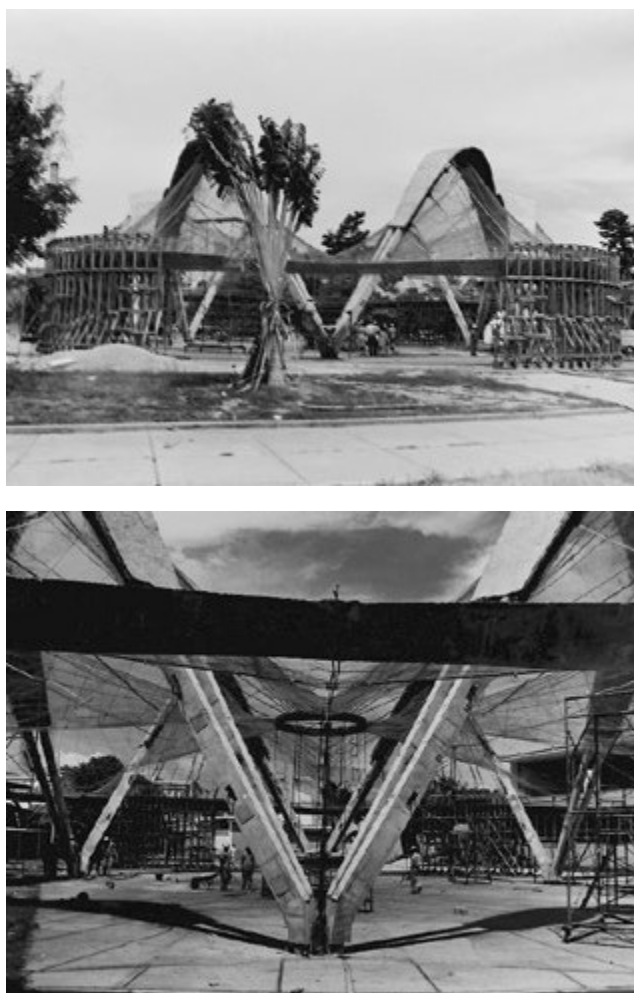
Ryc. 2. Ryc.2 i 3 System konstrukcyjny podparcia powłoki
