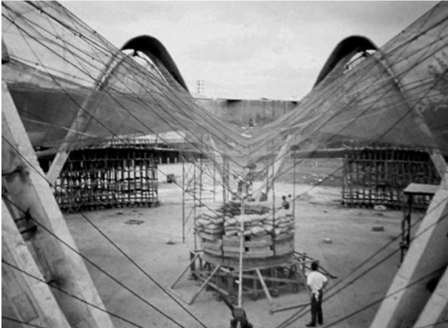
Ryc. 3. Balastowanie pierścienia wewnętrznego i lina koszowa
