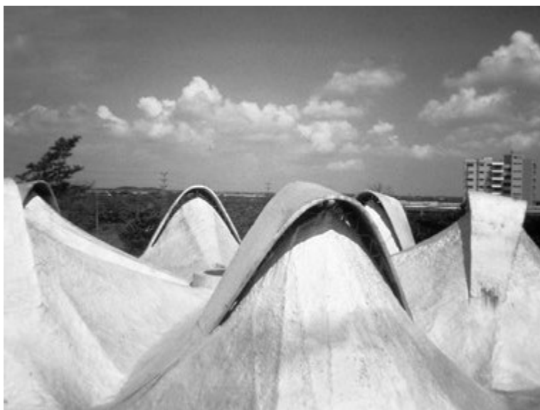
Ryc. 1. Widok zewnętrzny powłoki
