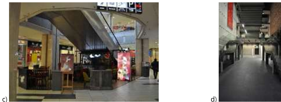
Ryc. 6. Ryc. 6. Schody w obiektach użyteczności publicznej: A – Politechnika Wrocławska C-13, niezabudowana przestrzeń pod biegami schodów, wprowadzony żółto-czarny pas ostrzegawczy na policzkach schodów; B - Dworzec Wrocław Główny – przestrzeń pod niezabudowanym biegiem oznaczona polem ostrzegawczym, dodatkowo wprowadzone elementy małej architektury; C – Pasaż Grunwaldzki, Wrocław, przestrzeń pod biegami schodów wykorzystane na przestrzeń kawiarnianą; D – Centrum Spotkania Kultur, Lublin, niezabezpieczone przestrzenie pod niezabudowanymi schodami; fot. W. Jabłoński;
