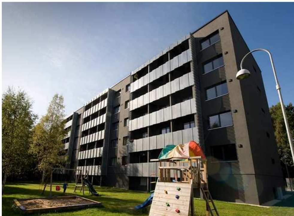
Ryc. 5. Modernizacja budynku z wielkiej płyty, Haapsalu, Estonia. Źródło ilustracji: http://www.professionals.ee
