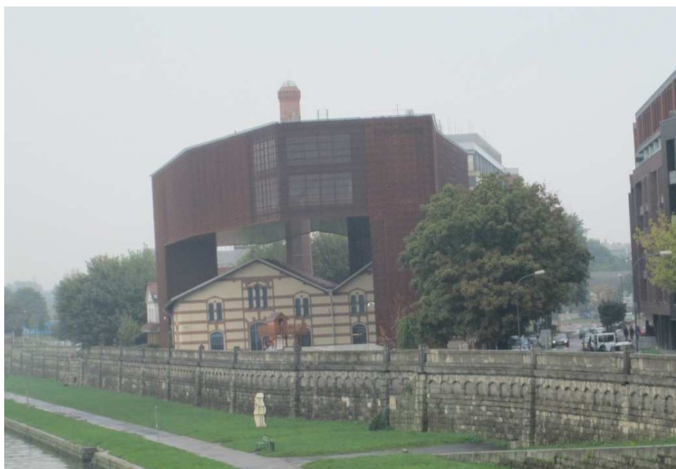
Ryc. 3. Siedziba Muzeum Tadeusza Kantora i Ośrodka Dokumentacji Sztuki Tadeusza Kantora Cricoteka w Krakowie. Wiodczna relacja nowej części z dawnym budynkiem elektrowni. Źródło: fot. H. Trammer, 20 września 2014 r.
