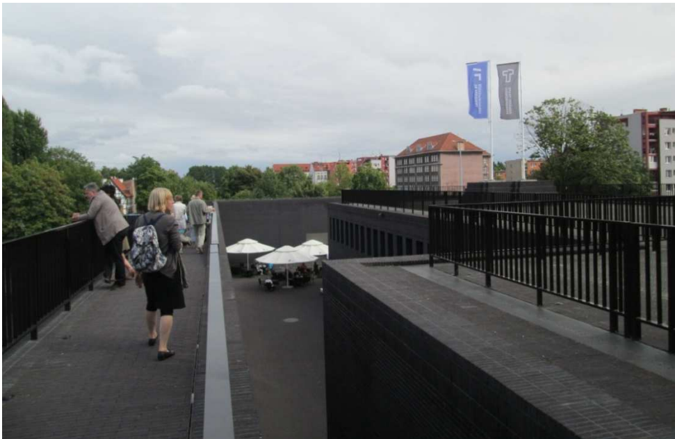
Ryc. 6 i 7. Gdański Teatr Szekspirowski. Widok z góry na część spośród dziedzińców obiektu. Źródło: fot. H. Trammer, 26 lipca 2015 r.
