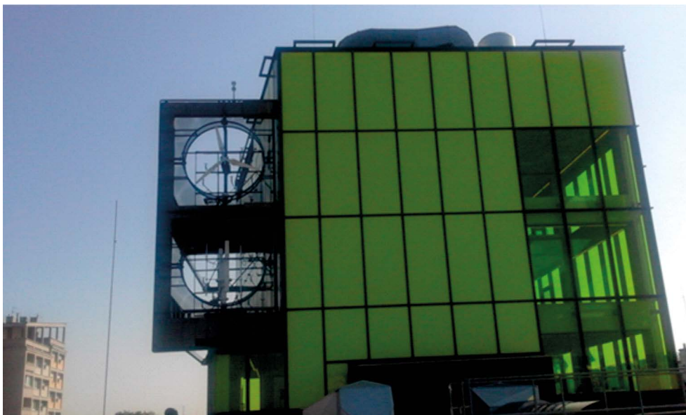
Rys. 1. Konfiguracja turbin przy elewacji budynku Centrum Energetyki (u góry turbina o osi poziomej, na dole turbina o osi pionowej)
