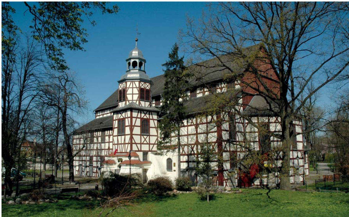
1. Jawor, kościół Pokoju, widok od południa. Fot. G. Grajewski
