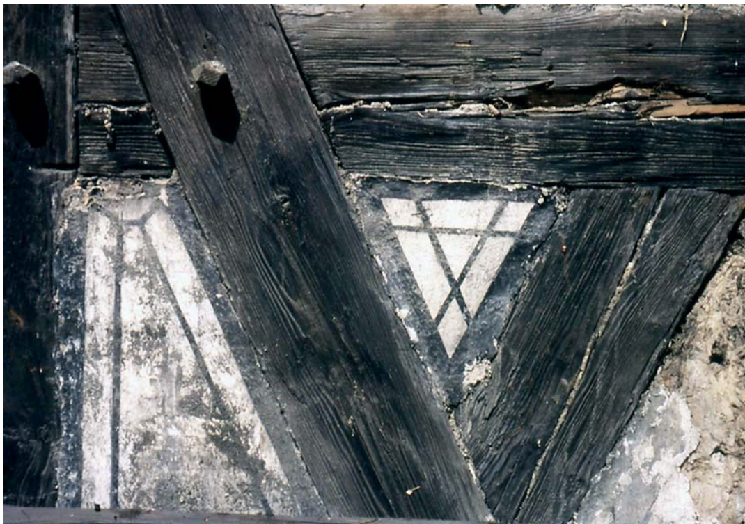
16. Świdnica, kościół Pokoju, południowa elewacja szczytowa, dolna kondygnacja, fragment pierwotnej kolorystyki ścian zewnętrznych. Fot. U. Schaaf
