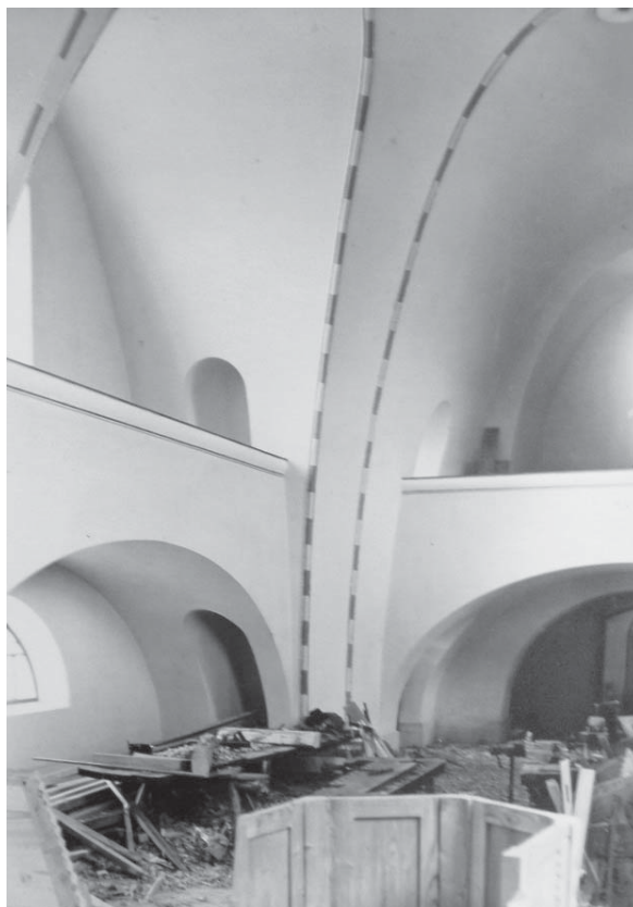
26. Wnętrze kościoła ewangelicko-augsburskiego w Istebnej podczas budowy. Fot. Archiwum ZAO, SOAK
