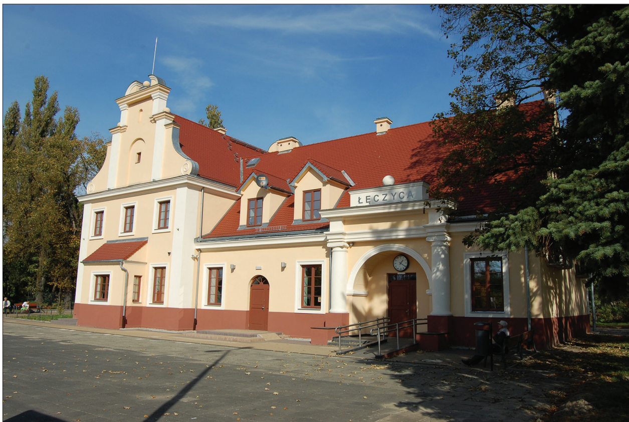
4. Dworzec kolejowy w Łęczycy obecnie. Fot. autor, 2014 4. Łęczycza Railway Station at present. Photo by author, 2014
