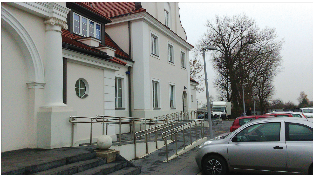
6. Dworzec kolejowy w Kole, rampa dla niepełnosprawnych przed wejściem do budynku. Fot. autor, 2014 6. Koło Railway Station, disabled access ramp at the front entrance to the building. Photo by author, 2014
