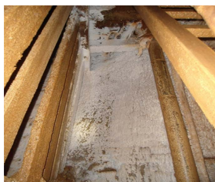
Rys. 14. Zanieczyszczenie obudowy osadem solnym Fig. 14. Contamination of support through the salt sediment
