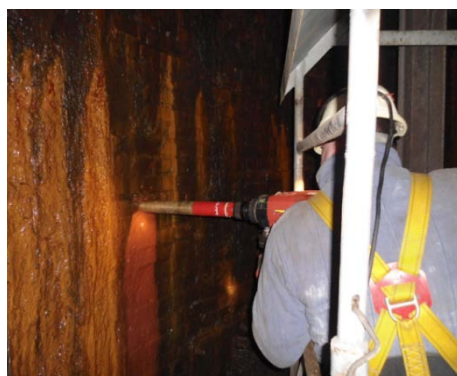
Rys. 4. Sposób pobierania próby rdzeniowej z podestu roboczego
