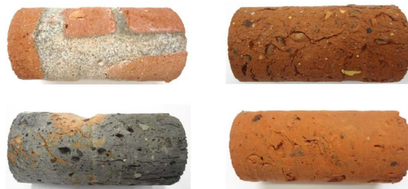
Rys. 25. Widok próbek pobranych z obudowy murowej szybu
