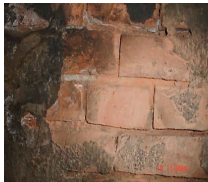
Rys. 22. Powierzchnia obudowy przygotowana do badań sklerometrycznych
