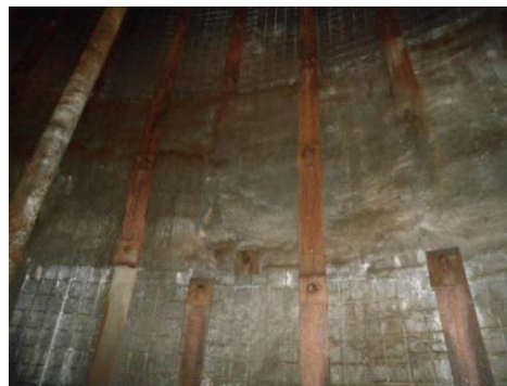
Rys. 6. Kawerna zamurowana i zabezpieczona przykotwioną siatką
