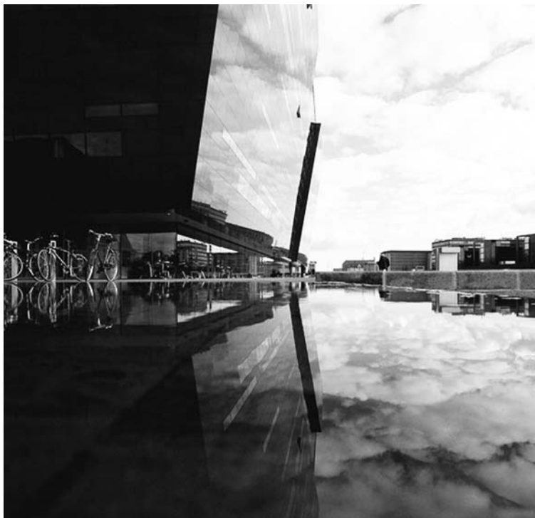
Fot. 4. Biblioteka Królewska w Kopenhadze. Widok od strony kanału portowego
