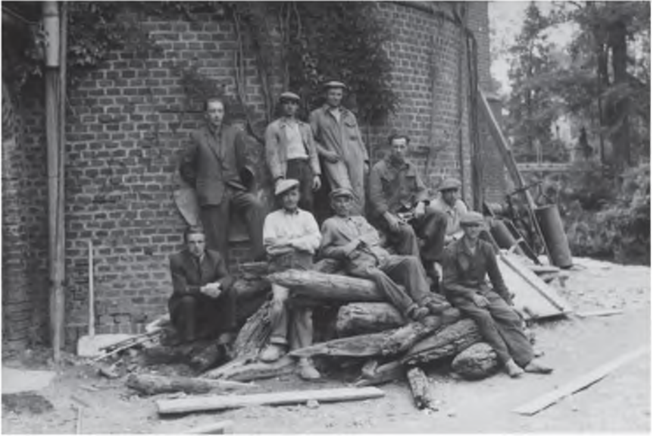
1. Prace budowlane w Zamku Kórnickim, pracownicy siedzą na stercie pali, ok. 1948 r. Fot. Zbiory Biblioteki Kórnickiej
