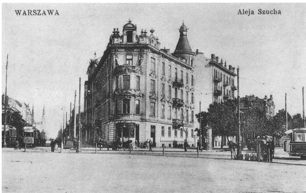
Il. 6. Widok z ronda Keksholmskiego (plac Unii Lubelskiej) na zbieg alei Szucha i ulicy Marszałkowskiej; nakład Bracia Rzepkowicz, 1911–1912, zb. MHW poz. kat. 74.
