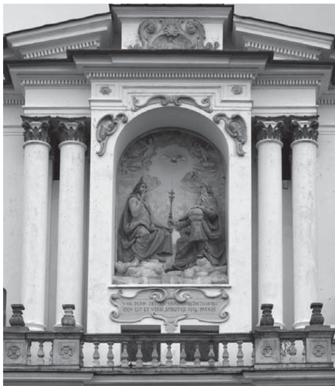
15. Fragment górnej kondygnacji fasady kościoła parafialnego w Tarlowie. Fot. A. Stankiewicz
