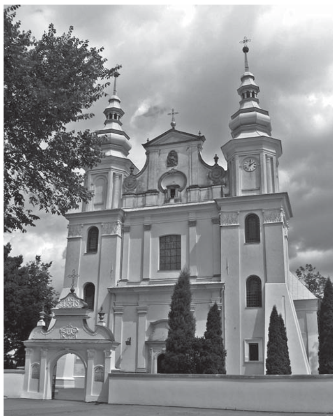
22. Fasada kościoła parafialnego w Jedlińsku. Fot. A. Stankiewicz
