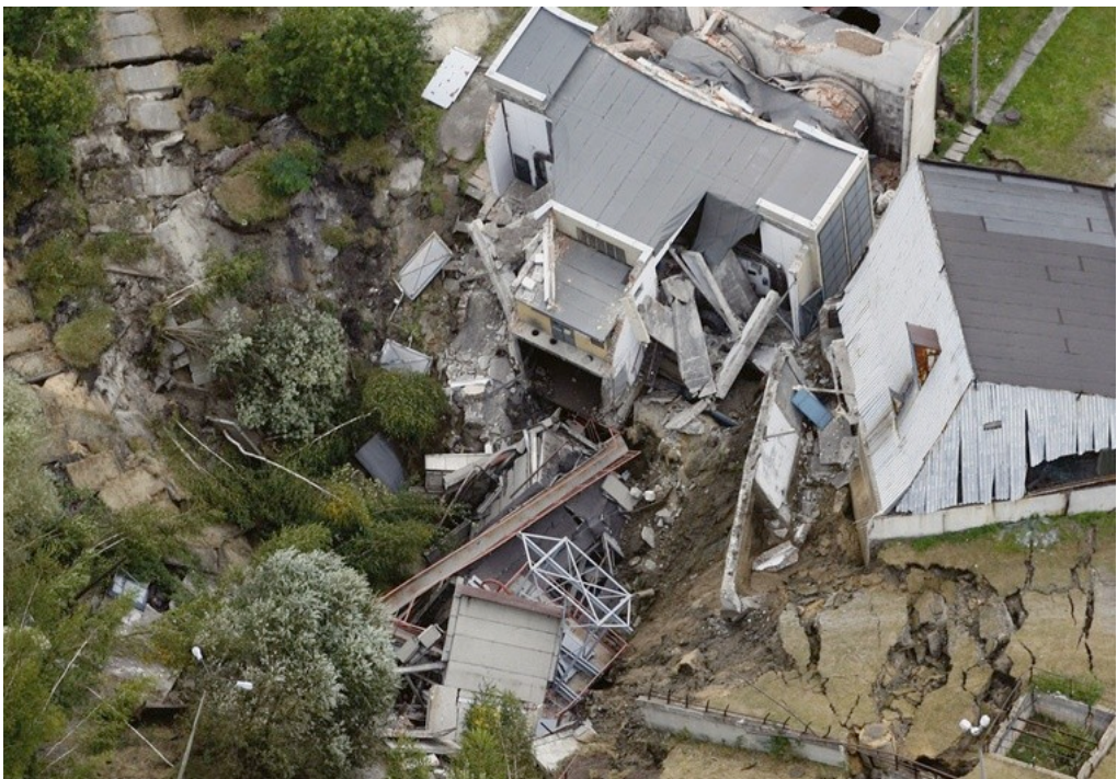
Fig. 4. Shaft Collapse – “Szczygłowice” Coal Mine (Dziennik Zachodni, 2008)
