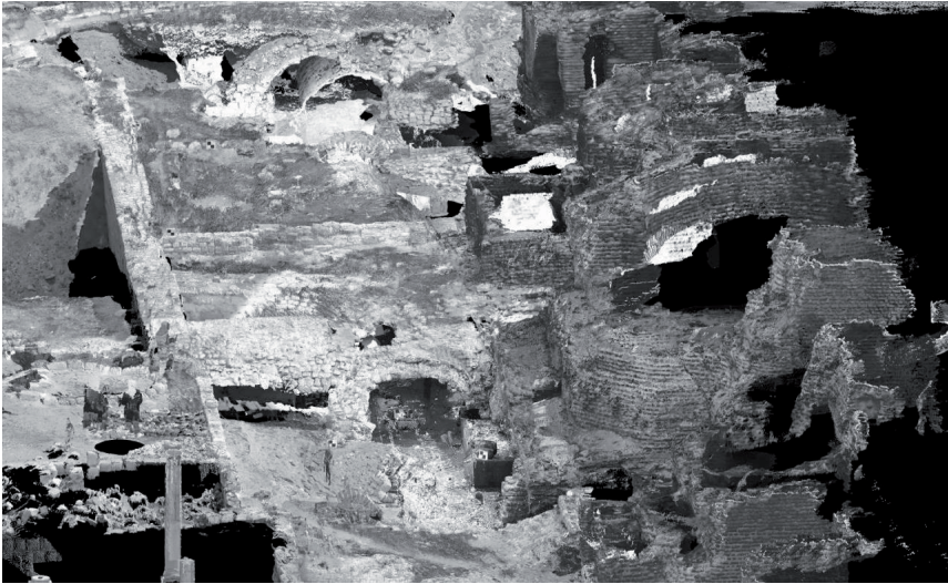
Rys 1. Obraz przekroju wykopu otrzymany za pomocą skaningu laserowego
