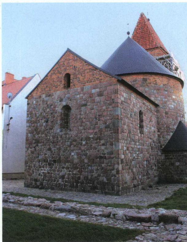
The St. Prokop rotunda in Strzelno
