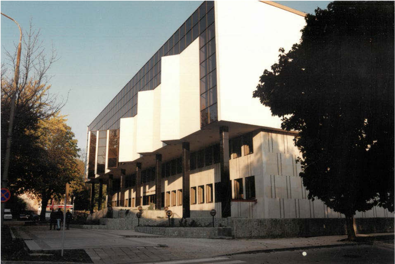
3. Elewacja południowa gmachu, fasada Filharmonii Lubelskiej (proj. S. Fijałkowski), lata 90. XX w., fot. A. Rożek, Archiwum Filharmonii im. Henryka Wieniawskiego w Lublinie
