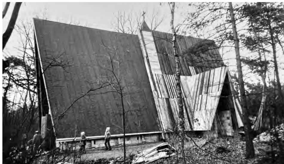
Il. 5. Prace wykończeniowe kościoła filialnego w Radzewicach. Jesień 1976. Zdjęcie ze zbiorów Marcina Libickiego
