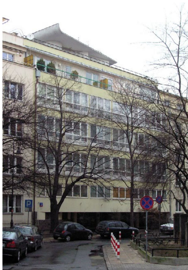
Il. Dom mieszkalny, Warszawa, al. Przyjaciół 3, proj. Juliusz Żórawski, 1935–1937. Fot. J.K. Lenartowicz 2010
