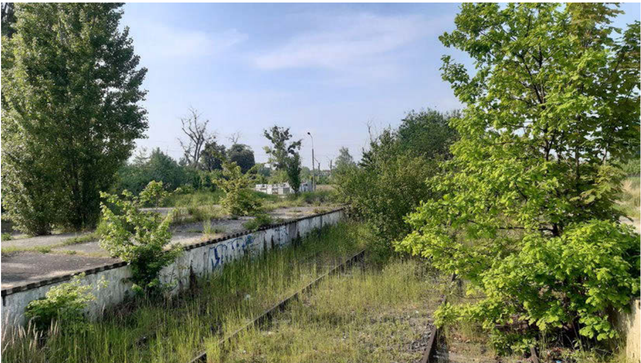
Ill. 8. Southern wedge: Former military barracks, a railway siding, and developing greenery. Photo by J. Rubaszek. Il. 8. Klin południowy: Dawne koszary wojskowe, bocznic kolejowa oraz rozwijająca się zielen. Fot. J. Rubaszek.
