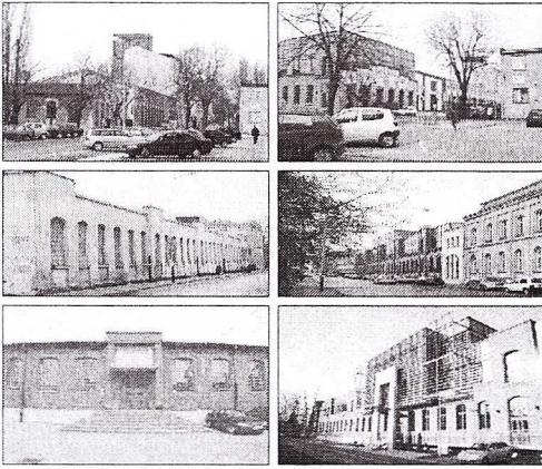
Fot. 13. Centrum Kształcenia Międzynarodowego – trzecie życie budynku tkalni fabryki Rosenblatta
