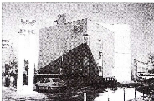
Fot. 4. Nowa hala sportowa Politechniki Krakowskiej
