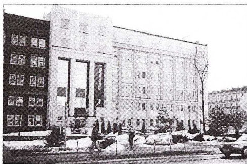
Fot. 3. Nowy ryzalit wejścia i nadbudowa Akademii Górniczo-Hutniczej
