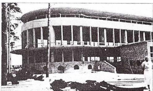
Fot. 5. Hala recepcyjna od południa, 1939 r.
