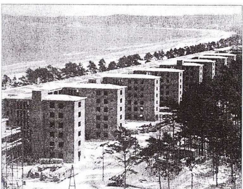
Fot. 6. Stan surowy, 1938 r.
