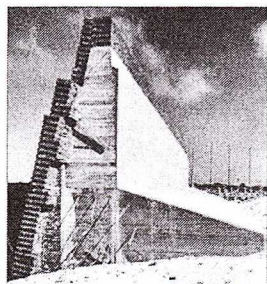
Fot. 2. Nabrzeże w budowie
