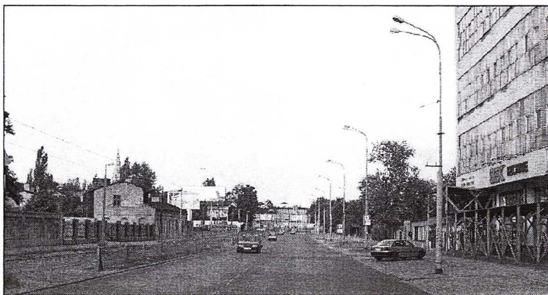
Fot. 10. Ulica zamykająca kompleks uczelni od strony południowej. Z lewej strony zespół PŁ fragmentem zaledwie dochodzący do ulicy, po prawej stronie opuszczone tereny przemysłowe. W tle osi ulicy rysuje się wieża Białej Fabryki przesłonięta zwartą zabudową ul. Piotrkowskiej
