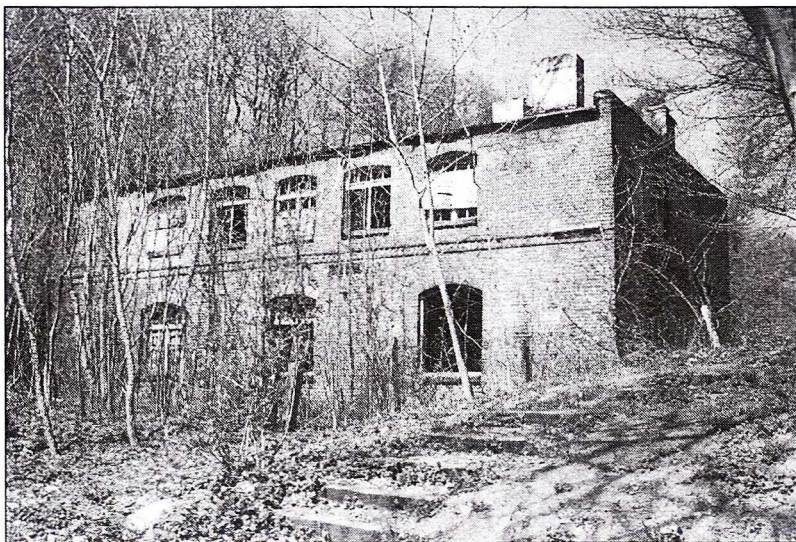
Fot. 1. Opuszczony budynek należący do kompleksu zabudowy Zakładu dla Ociemniałych
