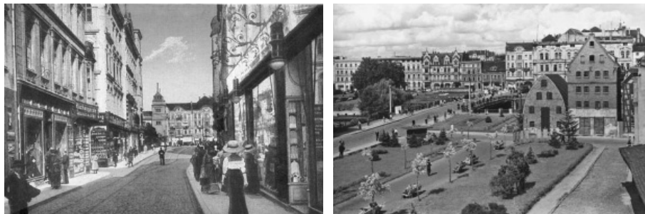
Fot. 4, 5. Widok ulicy Mostowej w Bydgoszczy w XIX w. i po II wojnie światowej.
